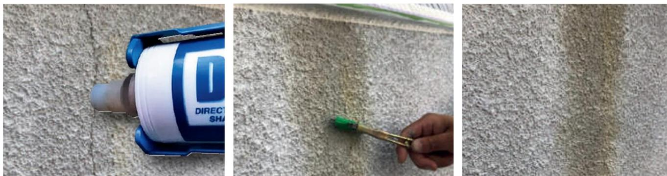
先端シリコンチップをクラックに対し垂直に軽く押し付けながら注入します。チップの前後から樹脂が盛り上がってきたらゆっくりとクラックに沿ってガンを動かして注入していきます。
