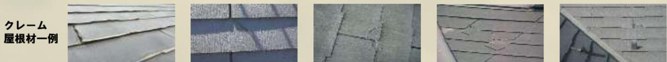
上記の画像の様に中央から割れていたり、端部が割れて落ちかけているような屋根は塗装を避けて下さい。アスベスト含有タイプからノンアスベストタイプへと屋根材が移行してきた時期に発売された物は特に注意が必要です。今の屋根材は丈夫になってきていますので安心して塗って頂けますが、少しでも気になる屋根がありましたら新築時の就工書類などで使用されている屋根材をご確認いただくか、弊社担当営業へお問い合わせ下さい。
