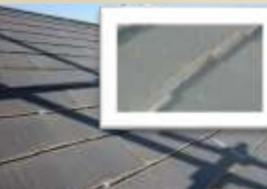
一見するとただのコロニアル屋根ですが・・・、屋根材がミルフィーユ構造となっており、すでに端部が捲れている。このような屋根がありましたら一度塗装を止めて屋根材の確認をして下さい!
